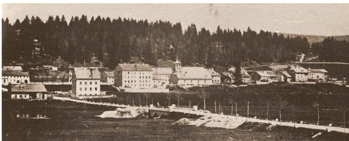
Nous sommes ici légèrement après 1860, au vu de ce qu'il semblerait être un chantier encore en cours au niveau du pont. Celui-ci a belle allure.
